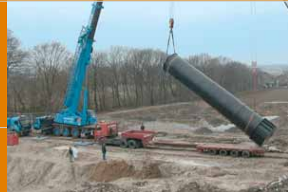
Einbau eines Sickerwasserschachts
