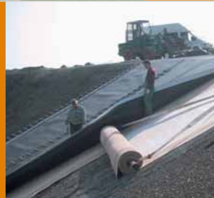
Einbau von Oberflächenabdichtungssystemen
