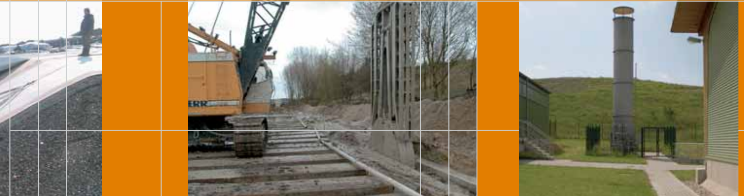
Herstellung einer Dichtwand
