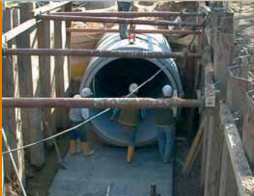
Kanalverlegung im offenen verbauten Rohrgraben
