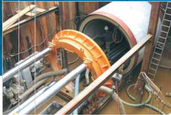
Kanalbau im Vortriebsverfahren
