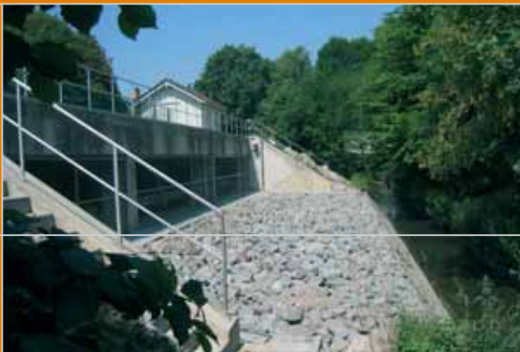
Stauraumkanal mit weit untenliegender Entlastung
