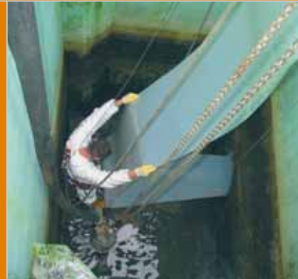
Kanalsanierung: Einzug der Schutzfolie
