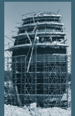
Kläranlage Münster, Faulbehälter in Segmentbauweise
